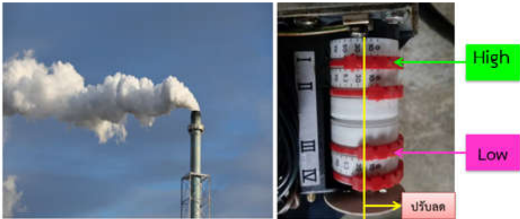
ภาพที่ 2-26 ลักษณะของปัญหาอากาศส่วนเกินสูงและการปรับลดปริมาณอากาศ
