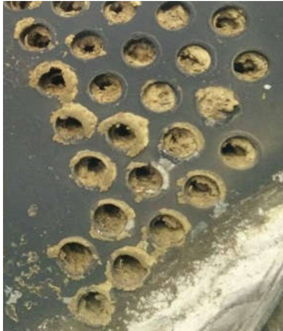
ภาพที่ 2-17 ปัญหาจากการใช้หม้อน้ำธรรมดา: คุณภาพการเผาไหม้ไม่ดี [4]
