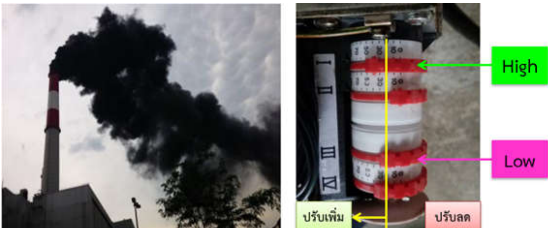
ภาพที่ 2-25 ลักษณะของปัญหาคันดำและการปรับเพิ่มปริมาณอากาศ
